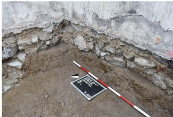
Fundamente Bestandsgebäude (SE 4) im Bereich Liftgrube Foto: V. Moser, ARDIG
