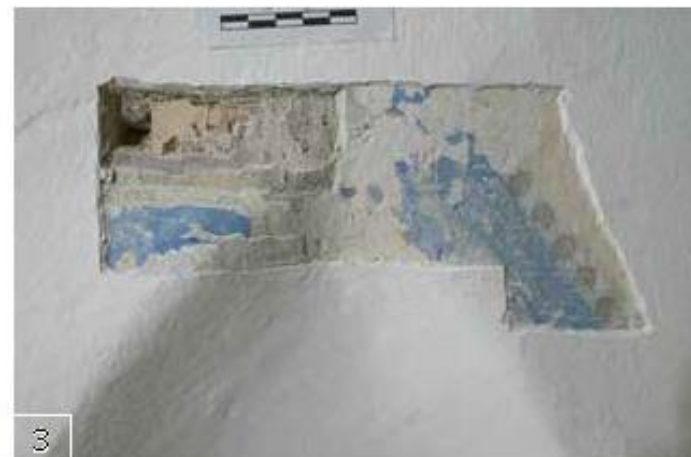
Stichkappe bei Nische, S-Wand, Ecke Ost; hier keine aufgeputzten Grate aber zahlreiche erhaltene Fassungs-schichten
